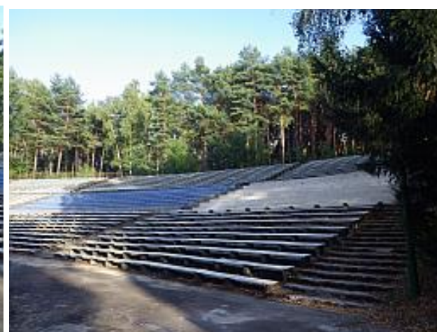
Fot. 4 Widok widowni
